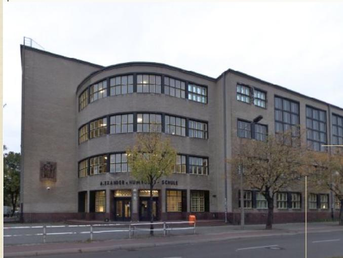
Im Übergang von der Rotunde zum Hauptgebäude in der 3. Etage lösten sich Anfang der 70-er Jahre des vergangenen Jahrhunderts Tontafeln aus der Fassade und schlugen auf den Fußweg. Daraufhin wurden nahezu alle Tontafeln am gesamten Gebäude entfernt und durch
