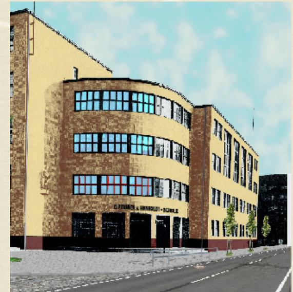
Computersimulation der mit Tontafeln verkleideten Fassade
